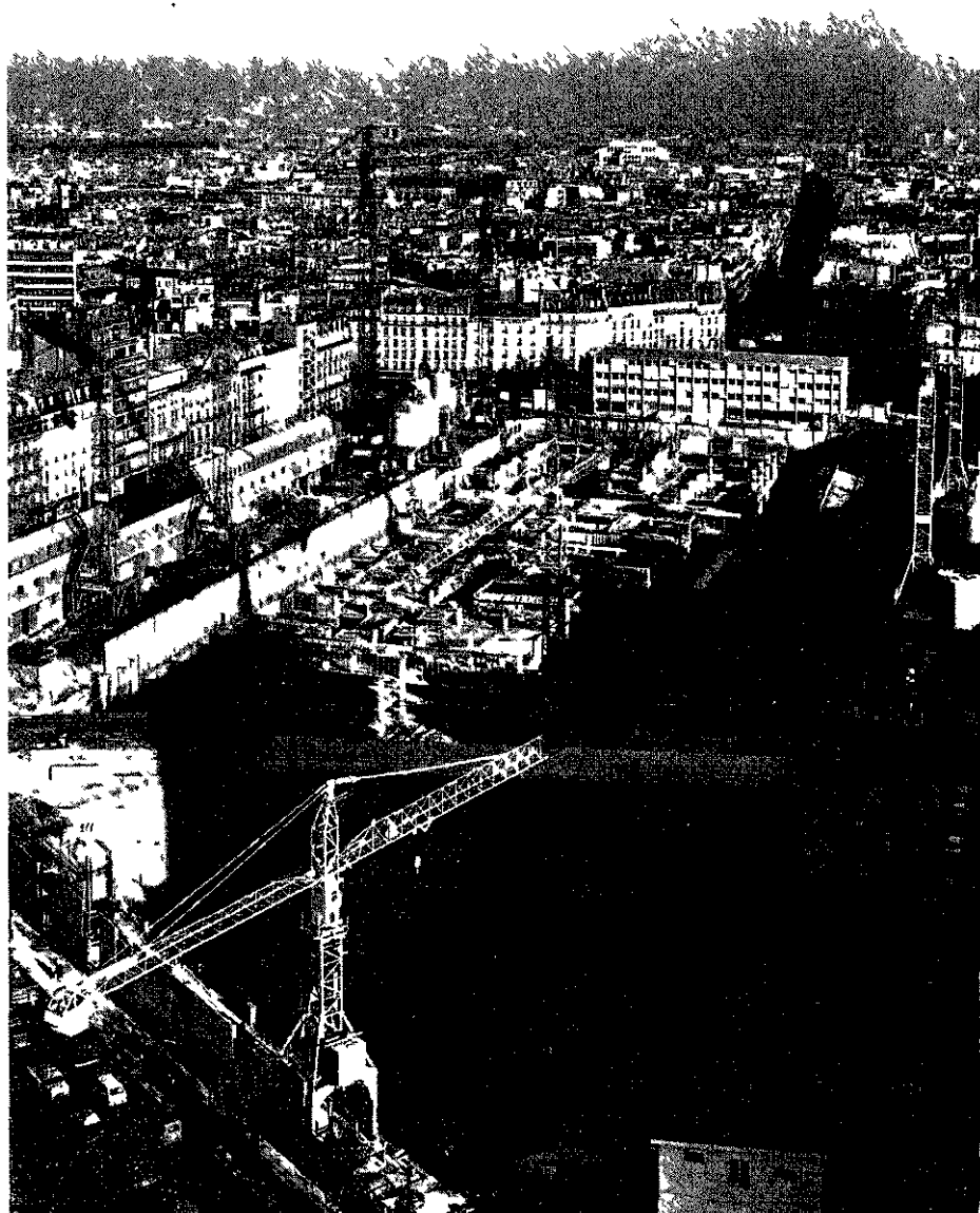
L'état des travaux au 25 novembre 1970
