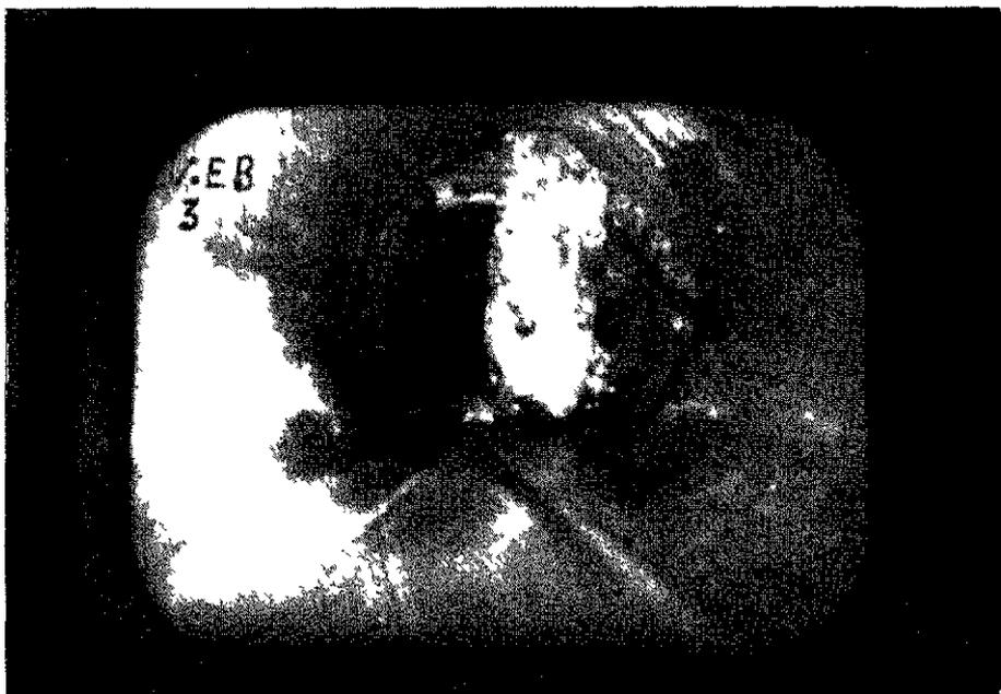
*Inspection d'un égout Ø 300 mm par caméra T.V. Un pieu a été planté juste au droit de la conduite !*
