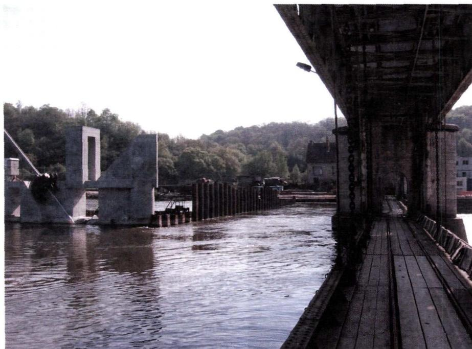
reconstruire. Des barrages à clapets, automatisés, permettront une manœuvre simple, sécurisée, rapide et synchronisée, améliorant ainsi la gestion de la ligne d'eau en limitant les effets des petites crues.
