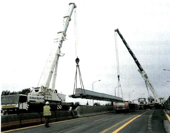
*Pose d'une structure centrale venant combler l'espace entre deux viaducs, eux-mêmes renforcés sur toutes leurs bordures, permettant l'élargissement d'une double plate-forme accueillant 5 voies en une plate-forme accueillant 7 voies. Solution originale permettant de gagner de la place en environnement très contraint.*
