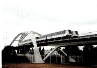
Ligne A du métro toulousain (maîtrise d'œuvre pour le compte de la SMAT) ; construction du viaduc de franchissement du périphérique (ouvrage métallique en arc de 83 m, mise en œuvre par remorque automotrice).
