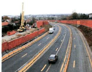
*Construction de murs antibruit sur la déviation de Colomiers. Hauteur 6 m, longueur 2,5 km.*
