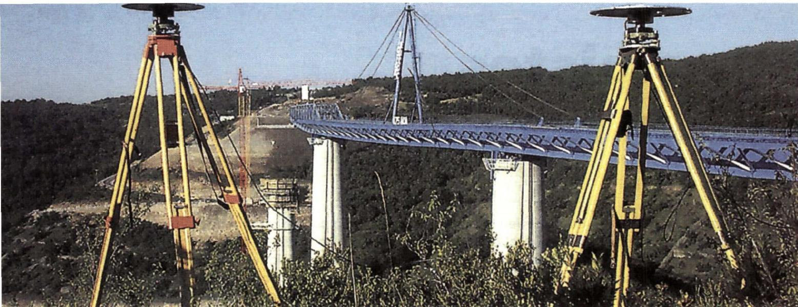
Contrôle des opérations par GPS sur le viaduc de Verrières, contournement de Millau.
