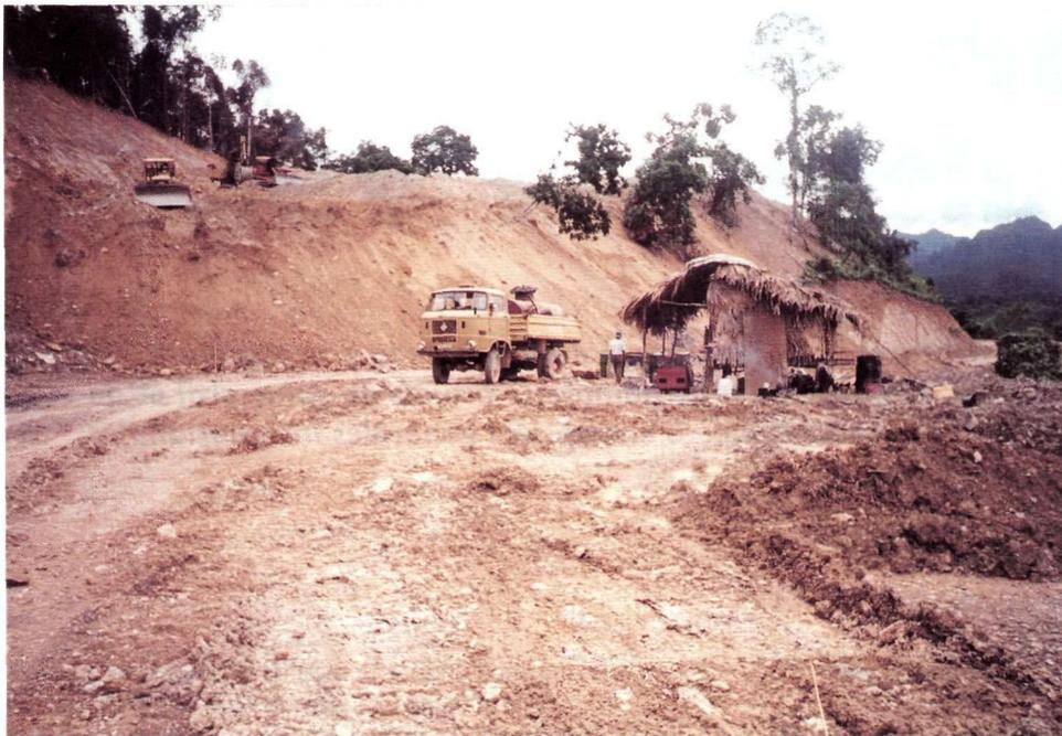
*Vue du chantier avec les bulldozers entrain de terrasser un versant de la montagne et au premier plan, un "bar" de chantier. Le remblai excédentaire sera tout simplement poussé dans les ravins sur votre gauche, la plate-forme routière restant toujours sur du déblai donc en principe pas de "problèmes de compactage !" et de tassement !*
