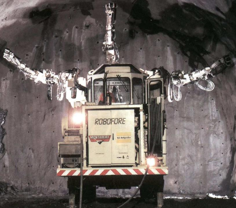
*Cette machine perforatrice creuse les trous dans lesquels sont placées les charges explosives.*
