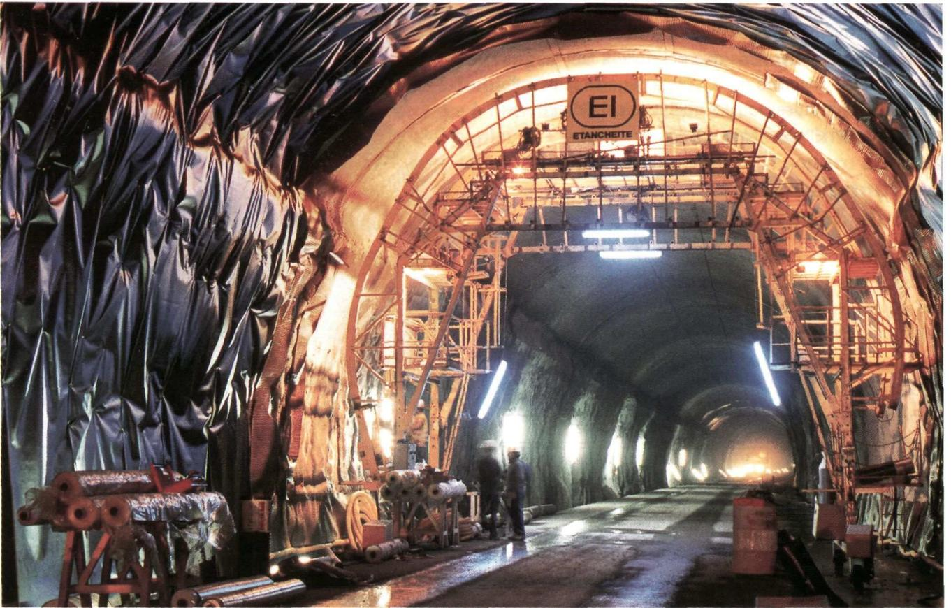
*Avant de construire la voûte en béton on place une feuille de polyvinyle qui assure l'étanchéité totale à l'eau du tunnel.*
