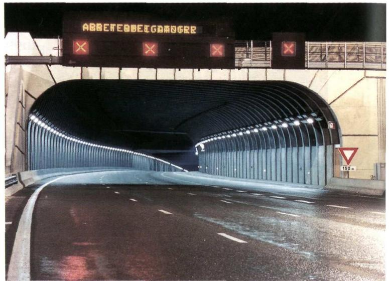
*Ce tunnel est en réalité une couverture artificielle destinée à protéger le voisinage du bruit.*
