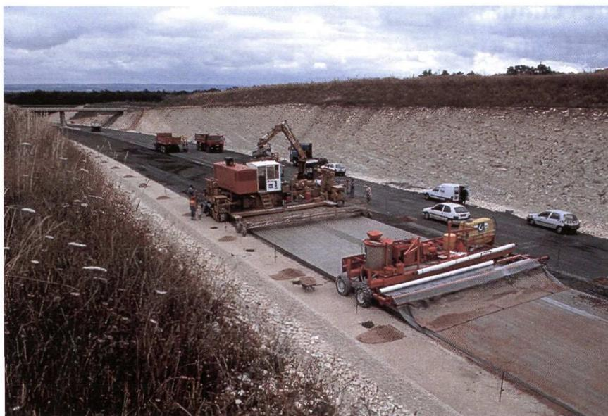
Déviations des Rassats-Favrauds, RN 141 (nord-est d'Angoulême). Vue générale du chantier de mise en œuvre de la technique du Béton Armé Continu "BAC" sur Grave bitume "GB".
