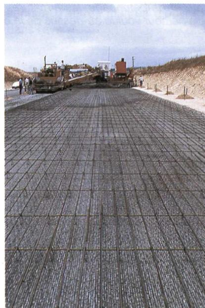
*Déviations des Rassats-Favrauds : avant l'atelier de bétonnage, les armatures du BAC sont positionnées, à mi-hauteur de la dalle béton, au-dessus de la couche de grave-bitume.*
