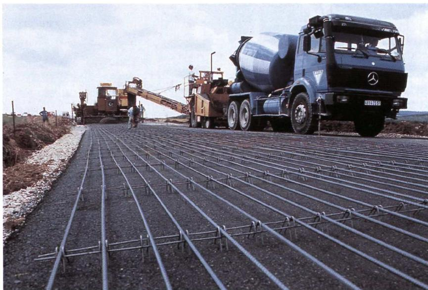
Contournement de la commune de Maizières (Meurthe-et-Moselle). Devant l'atelier de bétonnage, les armatures longitudinales du BAC sont positionnées à la hauteur voulue au-dessus de la couche de grave-bitume.
