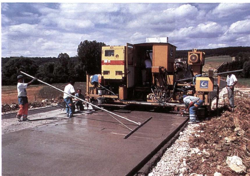
Contournement de la commune de Maizières (Meurthe-et-Moselle). Coulage du béton à l'aide d'une machine à coffrage glissant.
