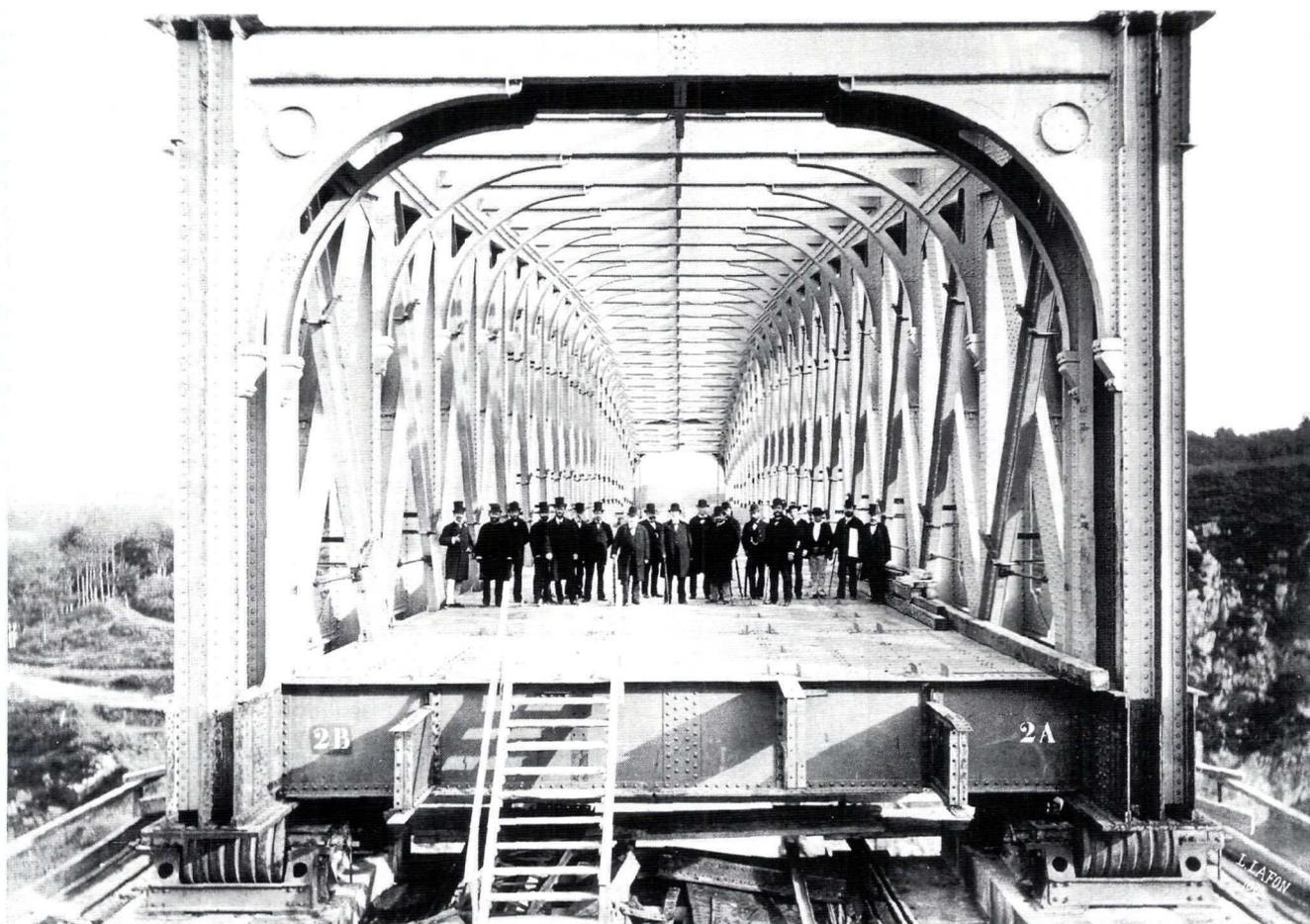
Mise en place par lancement de la travée métallique du viaduc de Lessart sur la Rance, 1879 - coll. ENPC.
