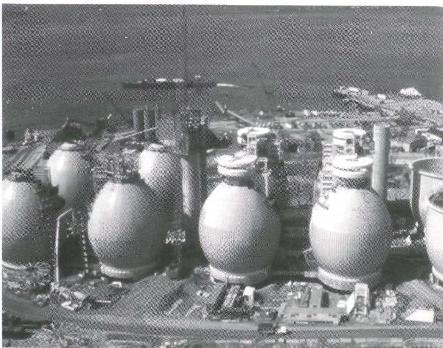
Fig.5 : Chaque digesteur a la dimension d'un immeuble de 14 étages. La boue digérée est transformée en engrais sous forme de granulés, utilisés sur des cours de golf, fermes, cultures d'agrumes et autres exploitations agricoles à travers le pays (doc. AWT).
