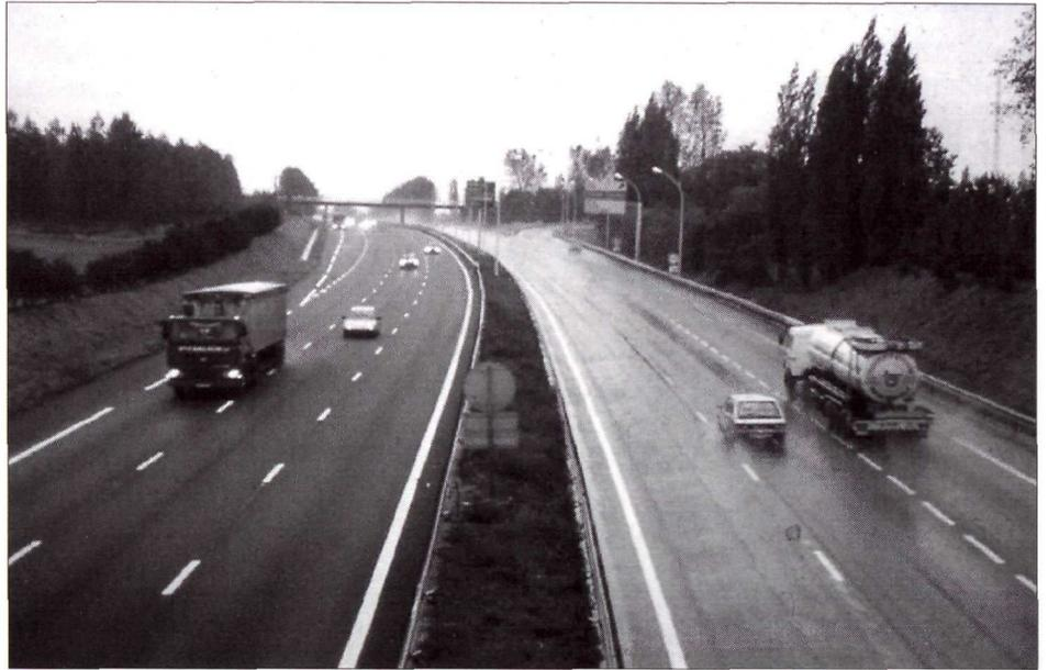
Innovation : chaussée poreuse (gauche) et non poreuse (droite).
