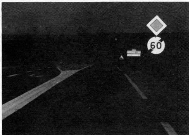
Les risques d'accidents plus importants sur CD justifient l'implantation d'une signalisation de qualité ainsi qu'un traitement en continuité : panneaux de police et jalonnement traités en Scotchlite Haute Intensité (homologué 10 ans) pour la sécurité et le confort de l'usager
