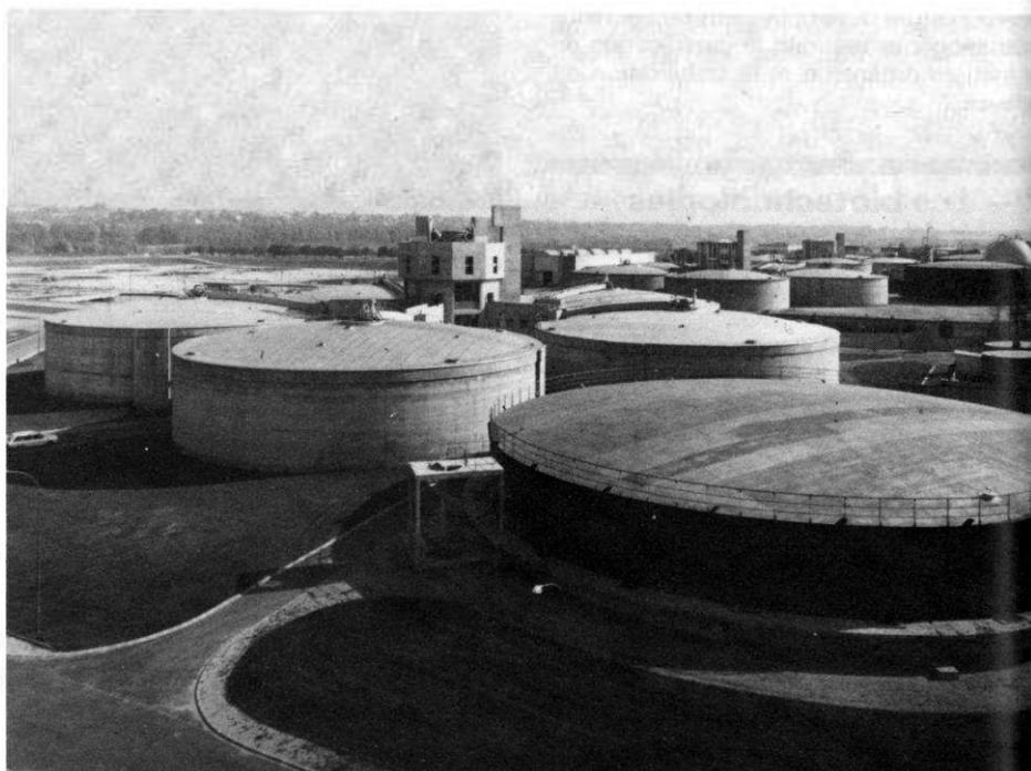
Fig. 6 : vue d'ensemble des fermenteurs de digestion anaérobie pour la stabilisation et la gazéification des boues résiduares de la station d'épuration de l'Agglomération Parisienne à Achères.
