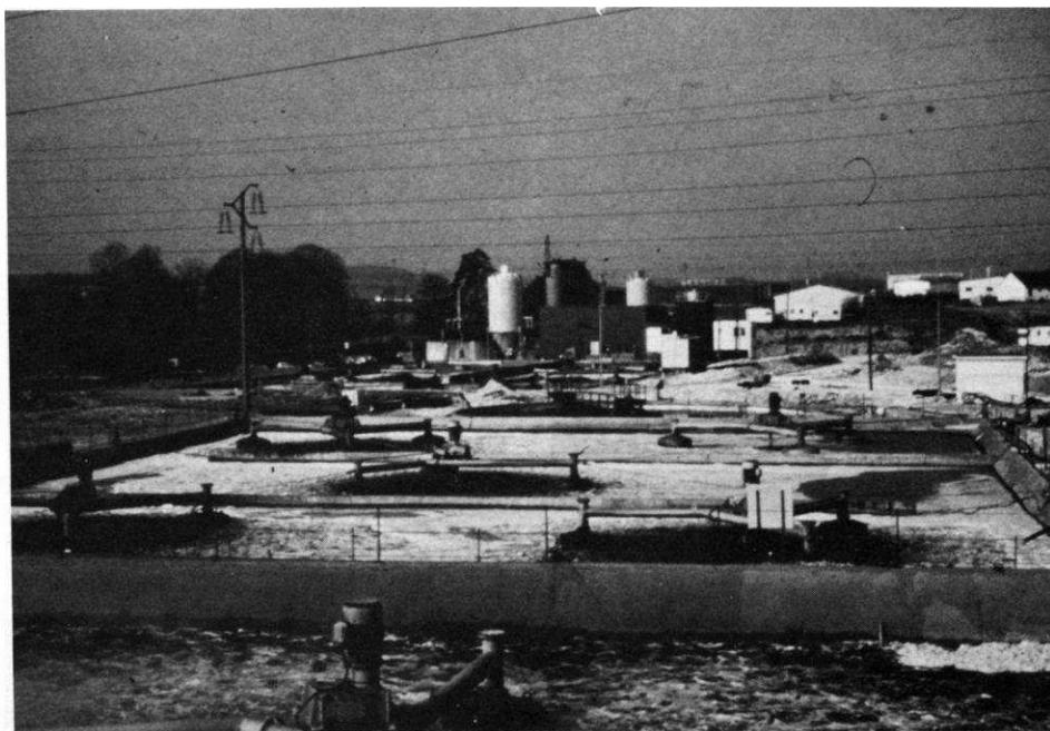
Fig. 5 : élimination de la pollution carbonée et de la pollution azotée avec dénitrification-nitrification des effluents de la Société Eurolysine (Amiens - France).
