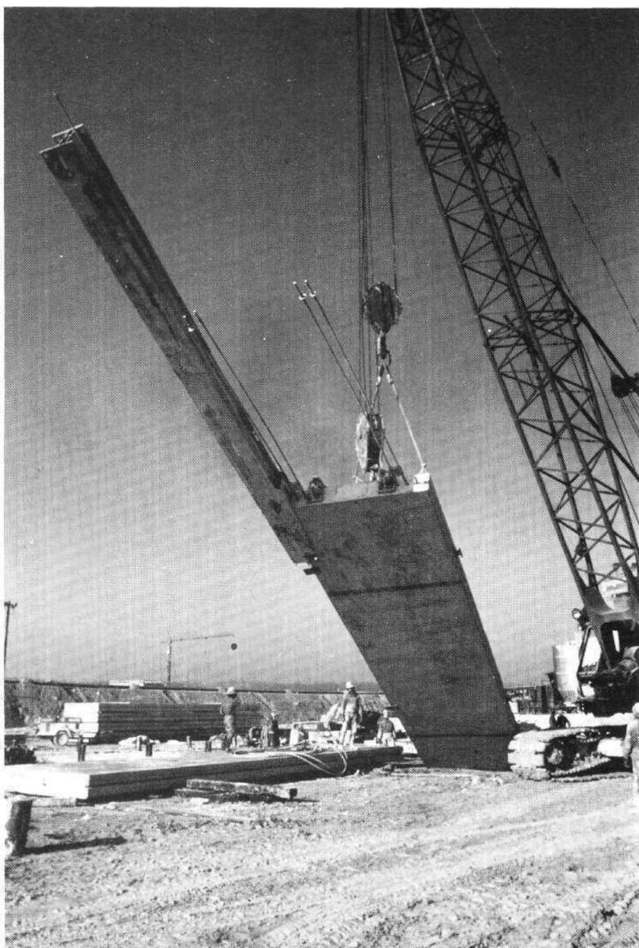
Mise en place d'un panneau préfabriqué (brevet Soletanche Panosol).
