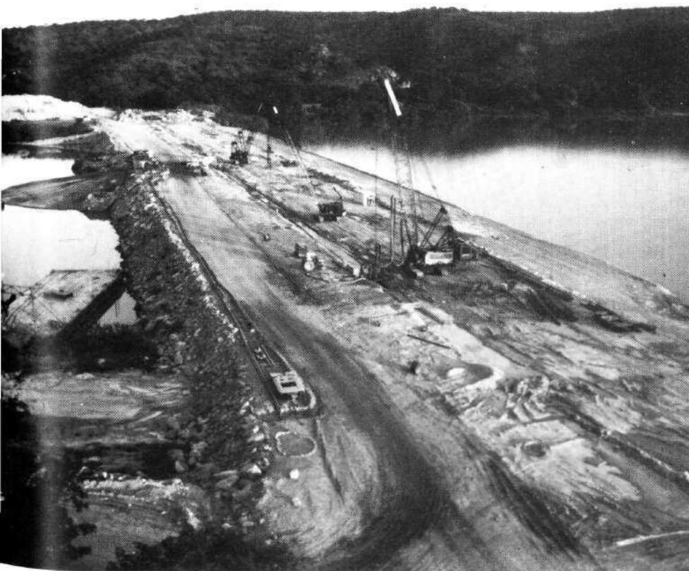
*Exécution d'une coupure étanche à l'hydrofraise.*
