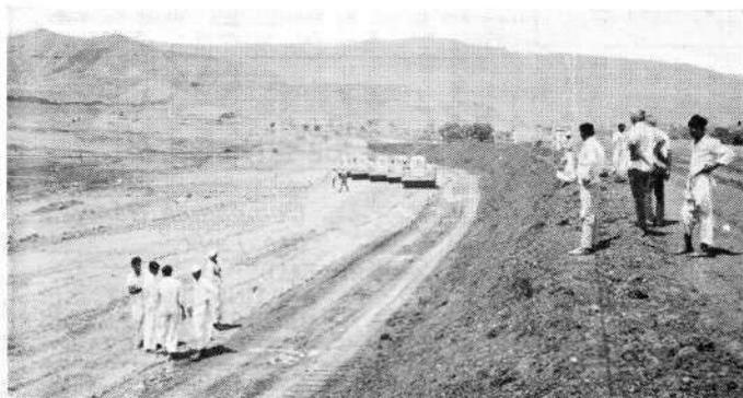
Le Sismopactor TT900, compacteur vibrant automoteur d'un poids total de 8,5 tonnes, a été retenu en raison de ses performances remarquables. De nombreux Sismopactor sont déjà en service depuis plusieurs années en Inde sur des chantiers de barrage en terre, sur lesquels leur efficacité et leur grande facilité d'utilisation ont été largement démontrées.
