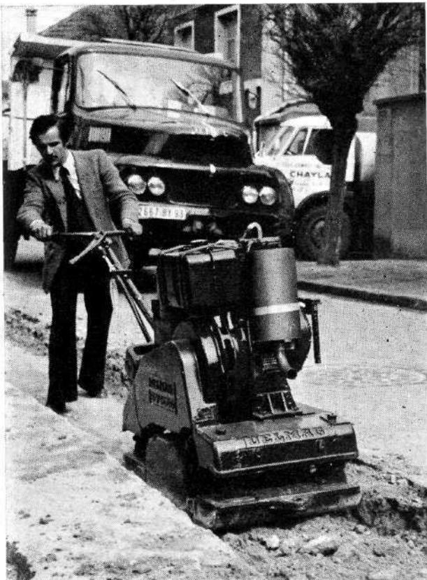
Problème difficilement soluble avec l'atelier traditionnel de compactage pour des largeurs de 550 mm minimum.
