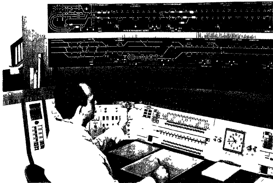
Poste de contrôle et de commande centralisés du réseau métropolitain Tableaux de contrôle optique et pupitre d'un régulateur de ligne
