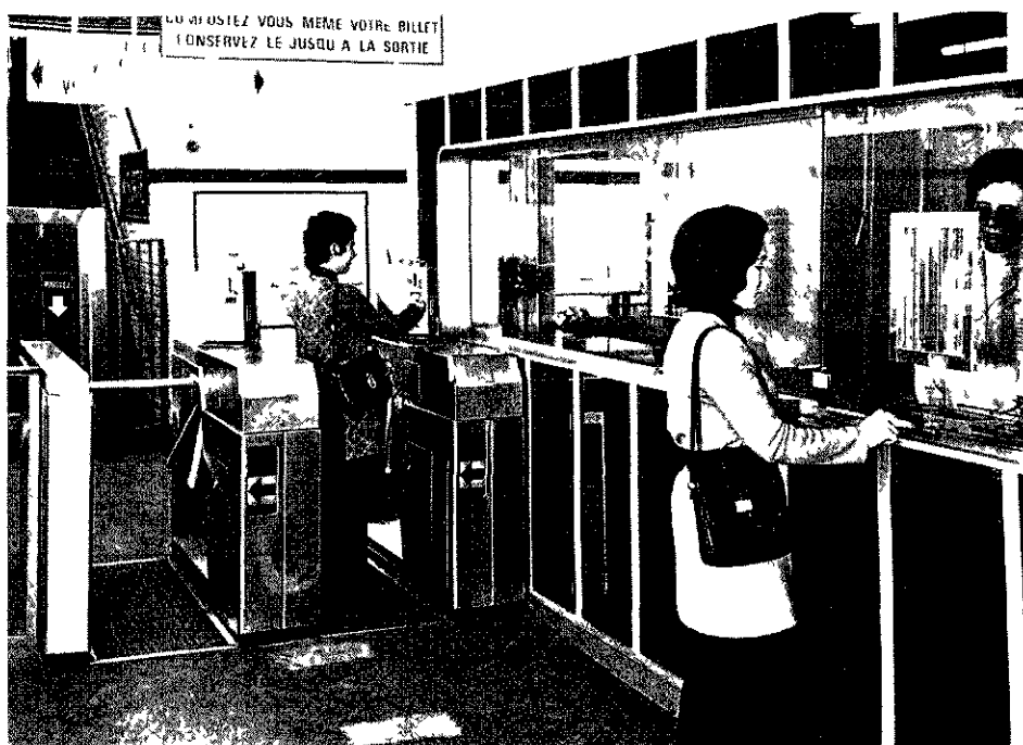
Réaménagement de la salle de recettes de la station Rennes pour le péage automatique par tourniquets et composeurs
