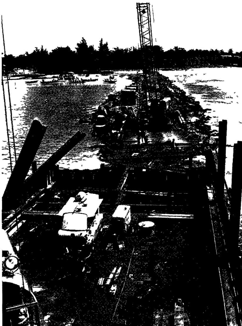
PORT DE COTONOU : Vue de la première cloison transversale en palplanches de la traverse le 25 avril 1964.
