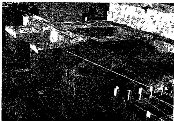
Fig. 35. — Dalle, nervures et contreforts
